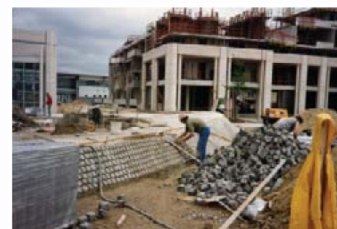
4 et 5 - Pose des pavés de granit gris et des galets de marbre blanc.
